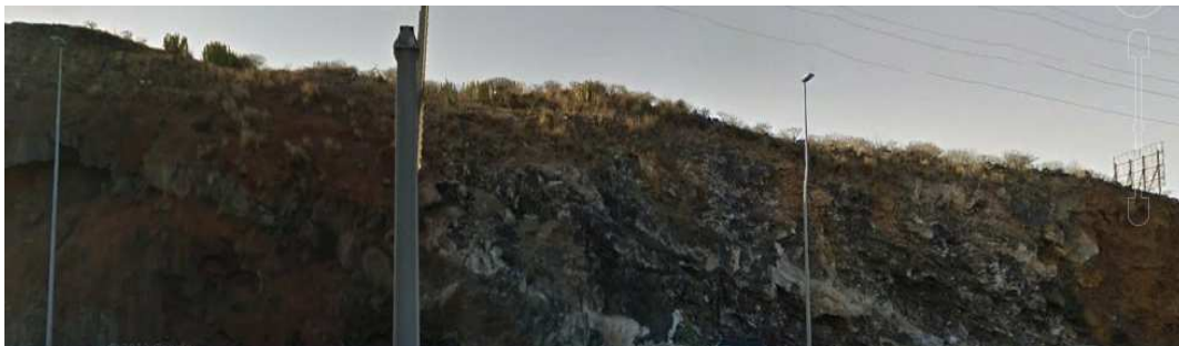
Talud de desmonte (salida 7 de la TF-1) en conglomerados volcánicos y coladas basálticas
